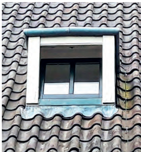
Dakkapellen worden voorzien van isolerende beglazing
