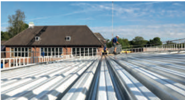
Nieuwe gymzaal in aanbouw
